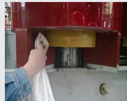
对线圈表面和所有垫块的各个角落进行擦拭
