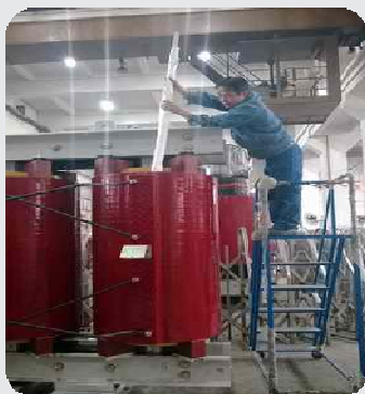
将包裹好抹布的绝缘杆伸入变压器线圈风道进行清洁
